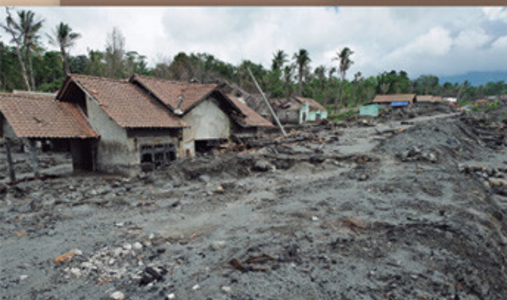
Destrucción causada por material volcánico arrojado por el volcán Merapi, isla de Java, Indonesia.
