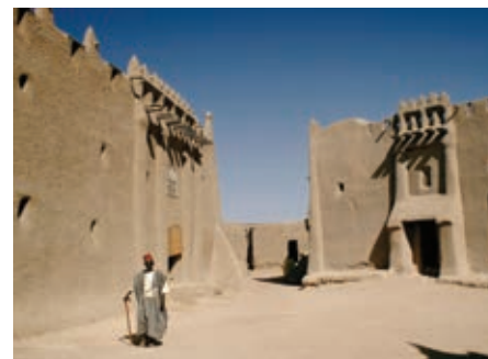
❖ Arquitectura de la ciudad de Djenné, en el delta interior del río Níger, Malí.
