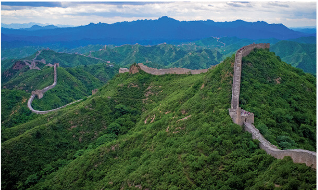
La Gran Muralla china, construida hace más de 2000 años, originalmente midió 21196 kilómetros, de los que hoy en día se conservan sólo 8 851.
