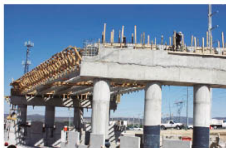
Construcción de autopista
