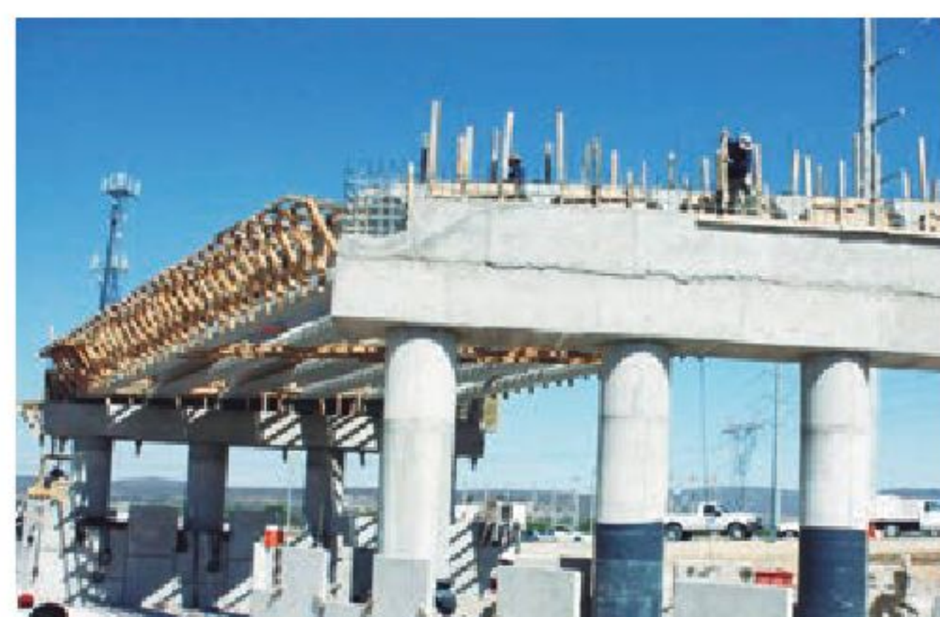
Construcción de autopista
