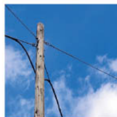
Figura 3.1. Poste de teléfono.
