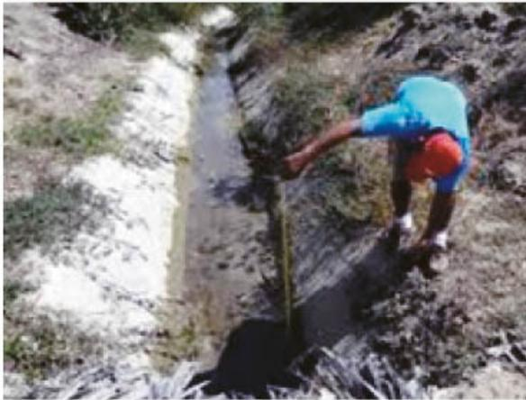
Fig. 2 Canales de riego en mal estado
