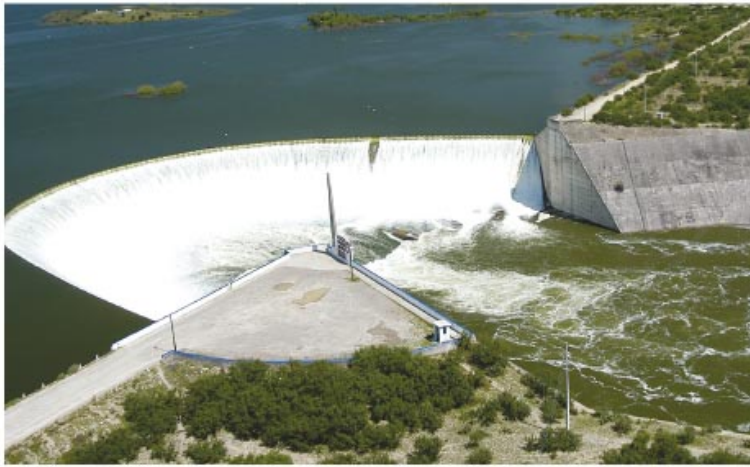
Figura 2.47 La caída de agua en una presa hidroeléctrica es la que mueve los rotores de los generadores.
