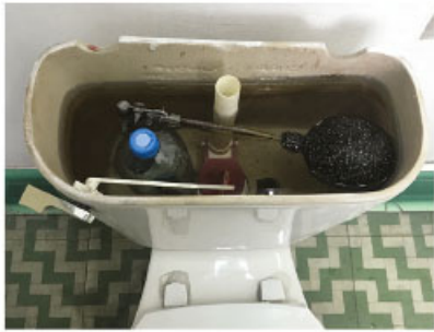
Figura 2.93 La botella puede colocarse de manera vertical u horizontal dentro del inodoro, lo importante para el ahorro de agua, es que se mantenga sumergida.
