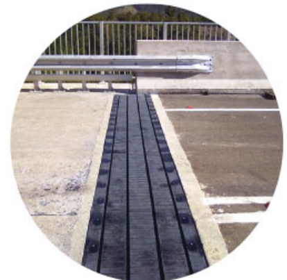
Figura 1.80 Para evitar que algunos puentes se deformen o se rompan, se colocan separaciones entre los bloques que los conforman.
