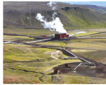
Figura 2.59 En una biorrefinería, el vapor producido al calentar agua aporta la energía cinética requerida para el funcionamiento de un generador de electricidad.
