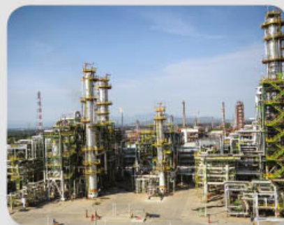
Figura 2.27 El craqueo catalítico se lleva a cabo en torres con controles electrónicos que regulan presión, temperatura, flujos y catalizadores.
