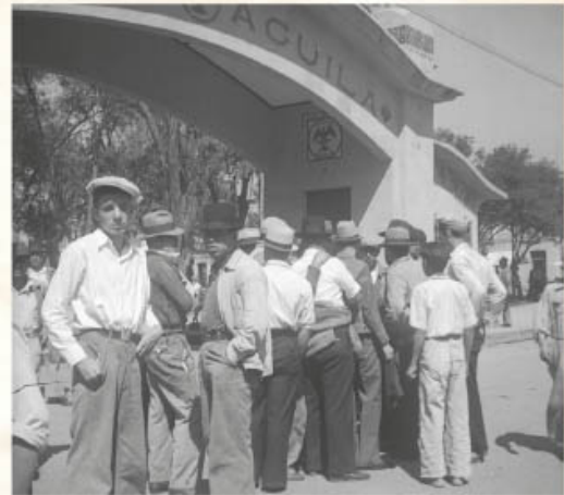
En 1938, la gran mayoría de las empresas petroleras eran de origen extranjero; entre las más importantes estaban la compañía inglesa El Águila y La Huasteca Petroleum de origen estadounidense. Trabajadores petroleros afuera de la compañía El Águila (1936).
